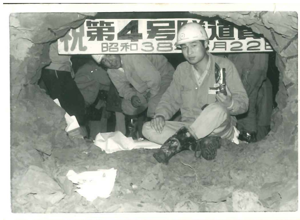
写真8-3 日向川発電所導水路トンネル貫通
