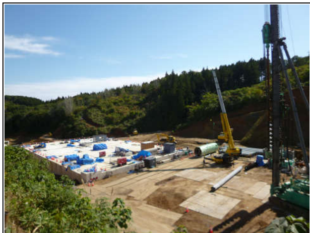
写真1. 大荒一般廃棄物最終処分場建設現場
