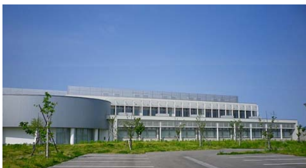
10/14 鶴岡サイエンスパーク (慶応、理研、スパイバーなどが入るラボ施設)
