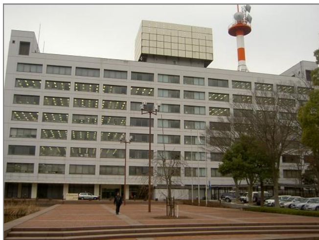
10/16 15:00～ 国総研&土木研究所
