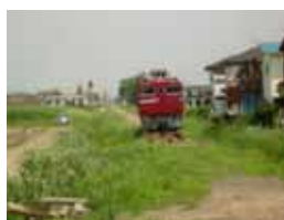
写真5、破壊された線路 常磐線。 - 山元町山下駅付近
