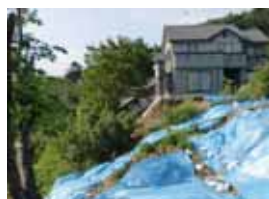
写真10、地すべりを起こした造成斜面、写真の奥に崩落した民家
