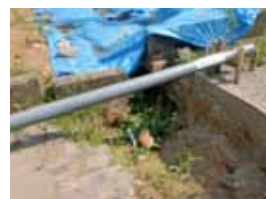
写真12、亀裂に伸縮計を設置
