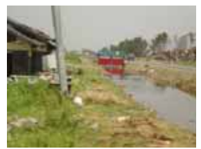
写真4、破壊された農業用水路。 - 巨理地区
