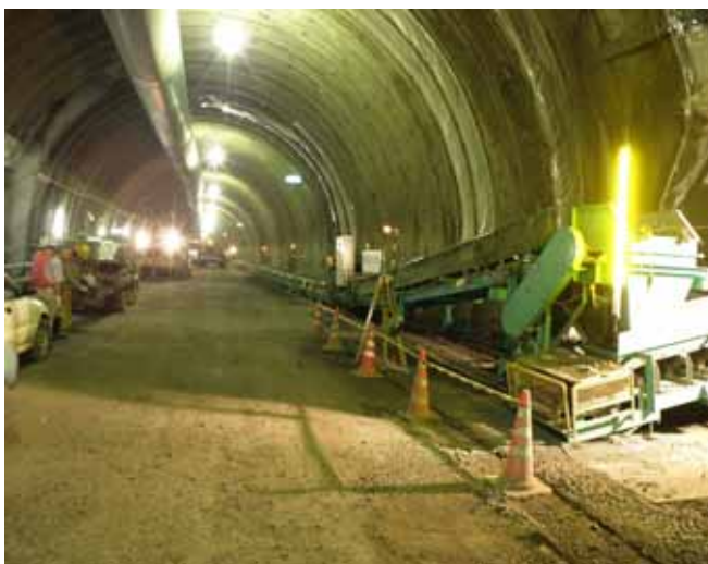
(温海トンネル吹付けコンクリート状況)
