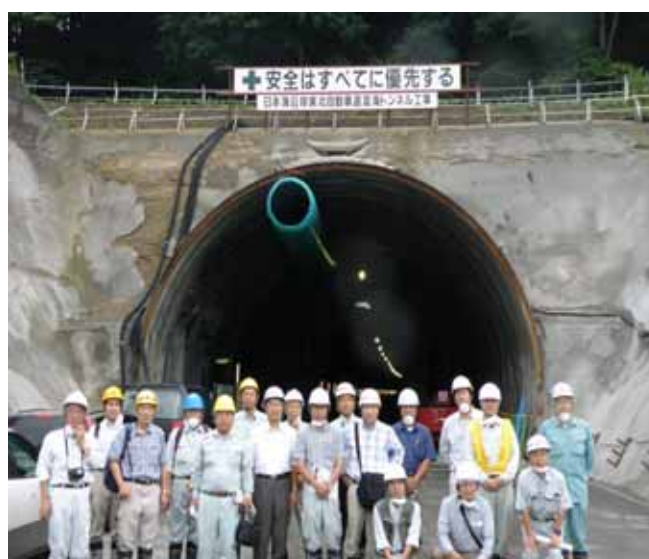
(温海トンネル坑口前にて)
