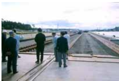
地震が来てもここだけは残る耐震埠頭の工事現場 (H12.10.11 酒田北港)
